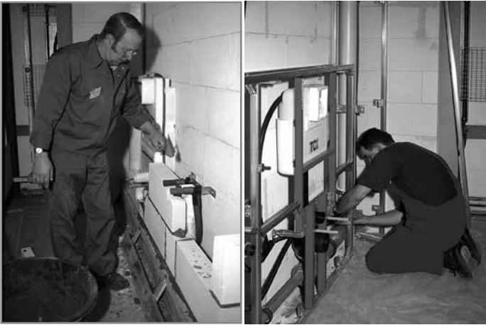
Кирпичная кладка (слева) против сухого монтажа
