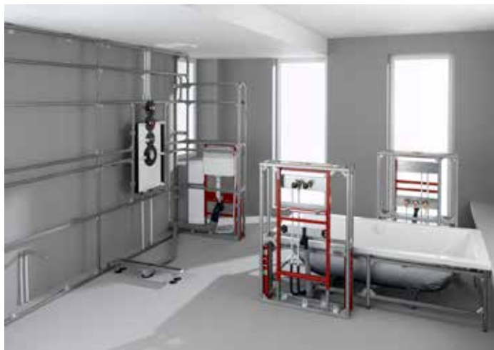
Стены ванной с TECЕprofil — до
