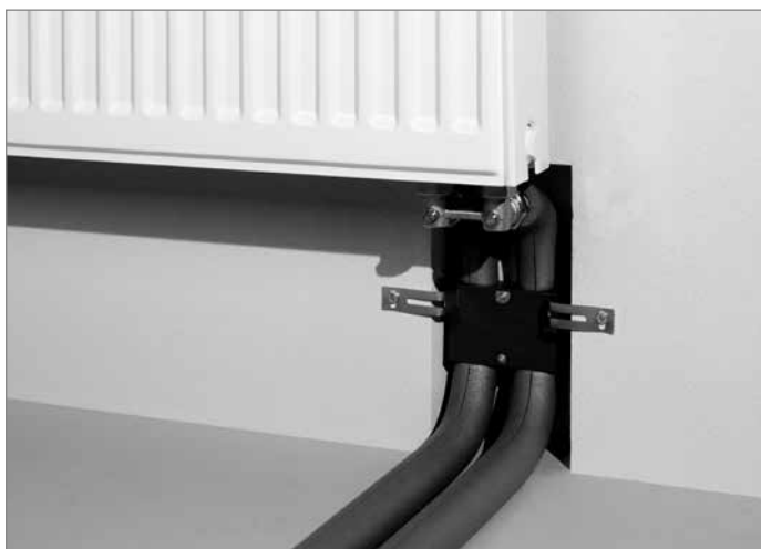
Подключение радиатора монтажным модулем — присоединён к клапанному узлу
