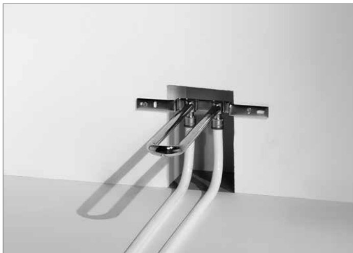
Подключение радиатора монтажным блоком — готово к опрессовке
