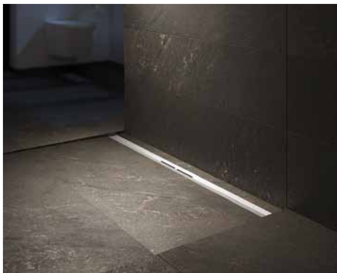
Монтаж «у стены»
