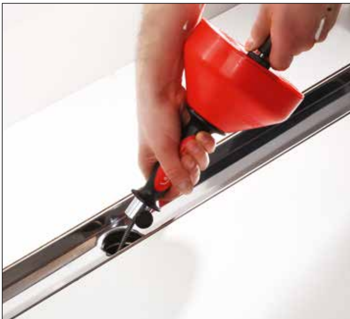
Прочистите сливную трубу маленькой ручной спиралью
